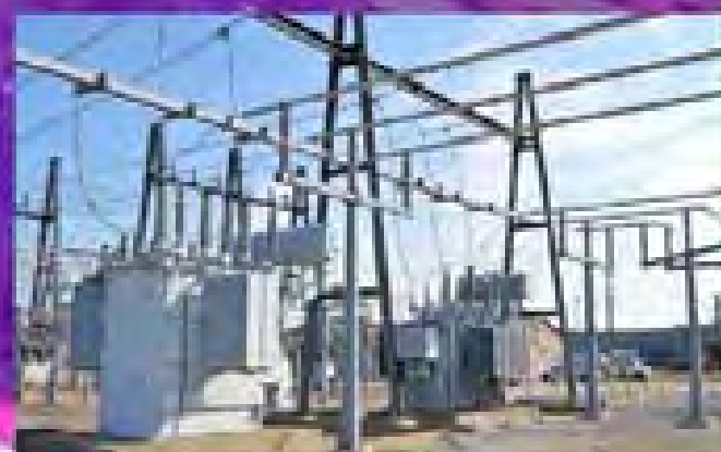
电力施工建设服务
